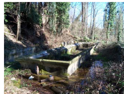
Il lavatoio di Bizzozero
